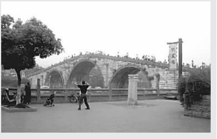
晨雾中古老的拱宸桥及运河沿岸,再现了“钱塘自古繁华”的胜景,成为市民晨练、休憩的好去处。
