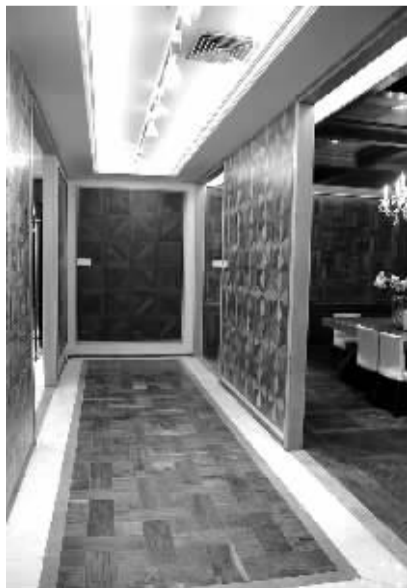
地板铺在了墙上
