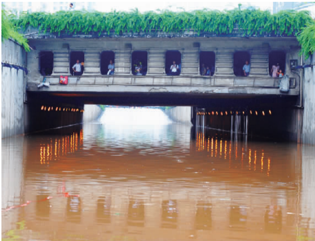
长沙市芙蓉路一段路面积水严重
