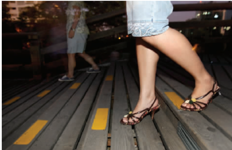
青园桥木条与木条间的缝隙约 1.5 厘米 见习记者 任 烨 摄
